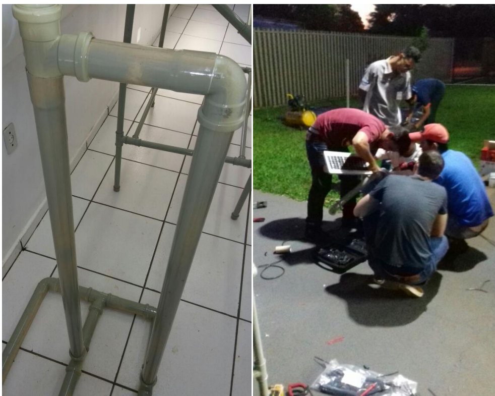
Figura 11. Suporte das placas solares. Foto: ODILON, Celso, 2017
