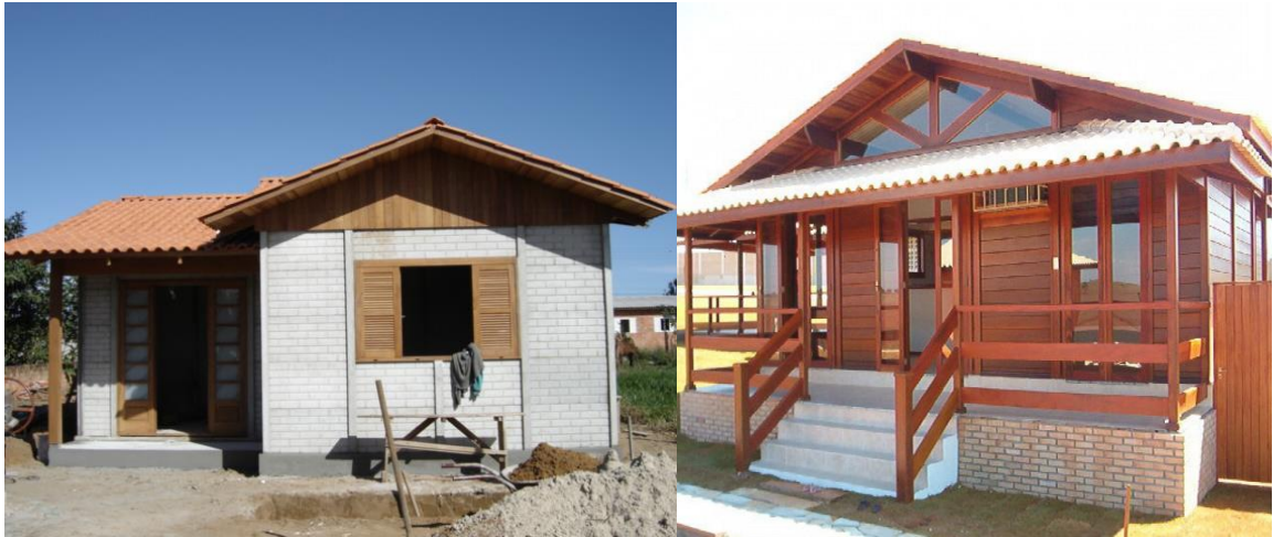
Figura 2 - Proposta de imóvel construída em placas pré-moldada e madeira
