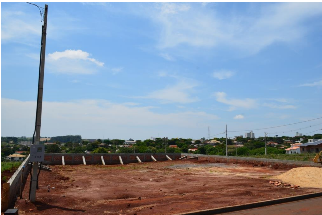
Figura 4 - Padrão provisório para construção
