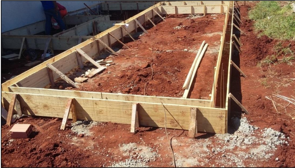
Figura 6 – Baldrame sendo construído.
