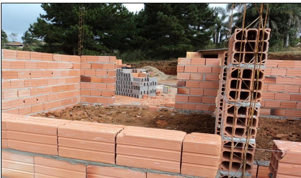
Figura 7– Início da edificação
