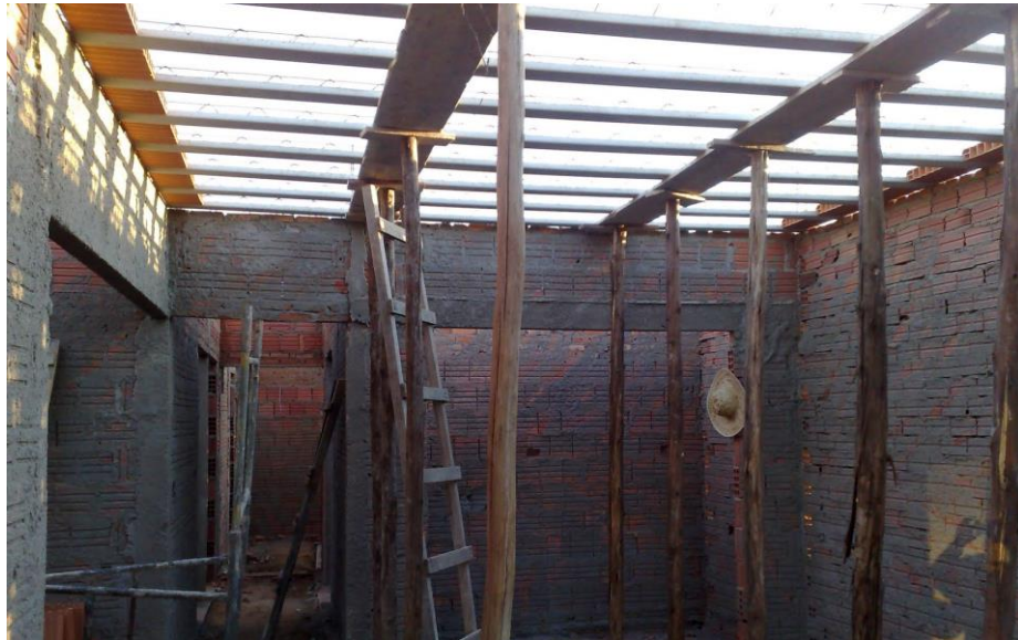
Figura 8 – Paredes chapiscadas e início da laje
